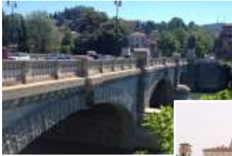
Pavimentazione, Ponte Umberto I
