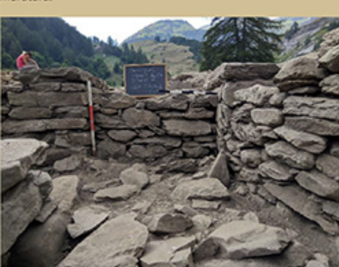
Tamponatura di un ingresso.
