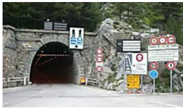
Tunnel di Tenda riaperto al traffico:... Completato nella serata di ieri (14 maggio) l'innesto ed eseguite le prove di tenuta con acqua in pressione, è stato subito avviato il...
