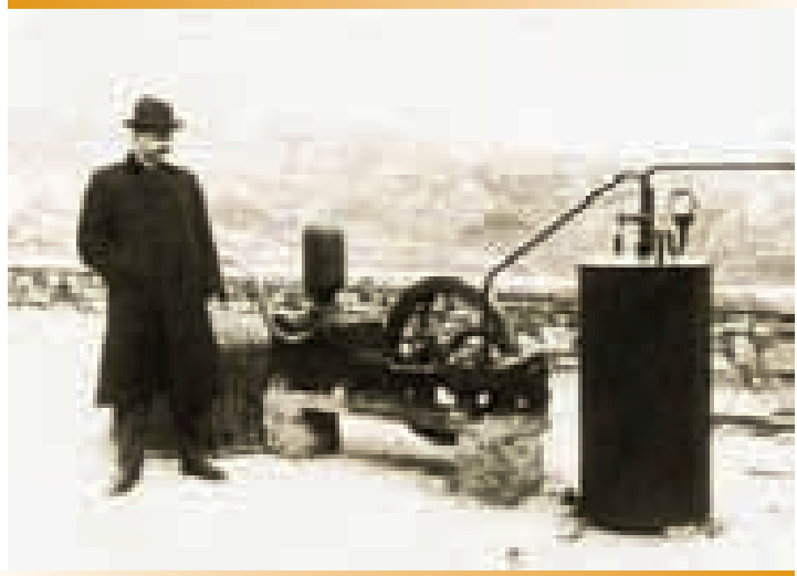
Figura 2 - Prima macchina che ha utilizzato il calore geotermico per produrre elettricità sviluppata nel 1904 a Larderello dal Principe Piero Ginori Conti (da Dickson M.H. & Fanelli M., 2004).
