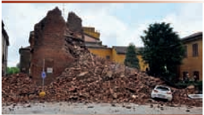
Figura 1 - Danni per il terremoto dell'Emilia del 2012 (foto Agenzia Sir).
