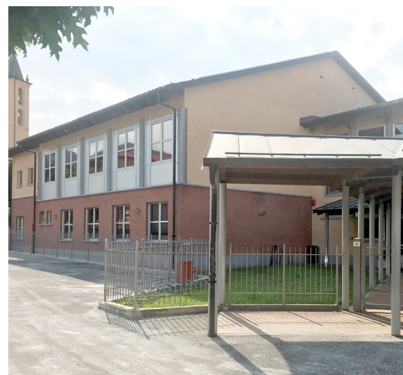
L'ingresso della scuola media di Piasco
