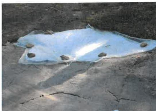
Foto particolare dell'impacco di polpa di cellulosa ricoperto da PVC
