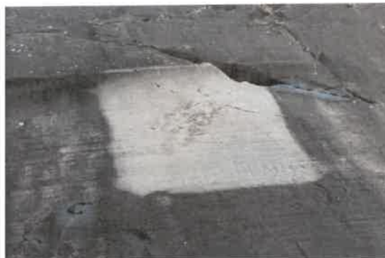
Foto particolare di un campione di trattamento e pulitura per la verifica di vitalità dopo il trattamento
