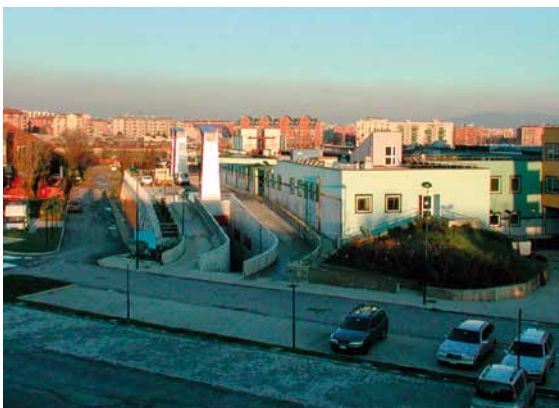
Il complesso edilizio dell'Ospedale Veterinario Universitario.
