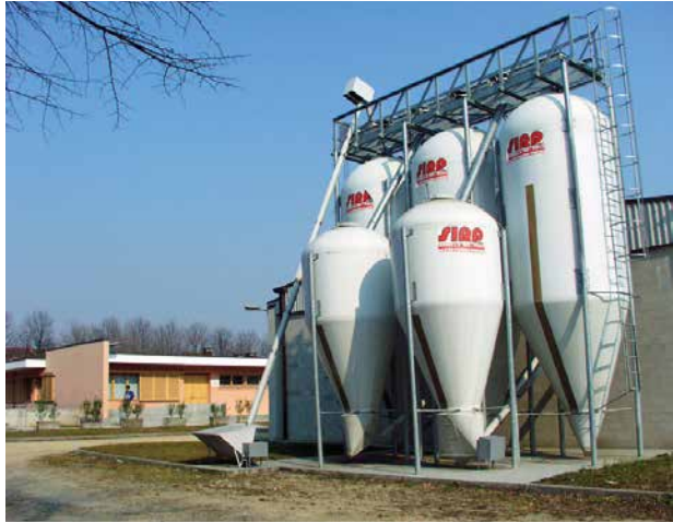
Silos delle materie prime annessi al mangimificio aziendale.
